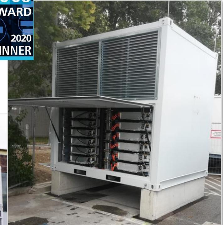
2020: Prototyp Stationär-/Mobilspeicher aus Elektrofahrzeugbatterien mit BMW und Siemens
